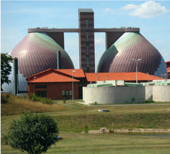
Die Faulbehälter des Klärwerks.
